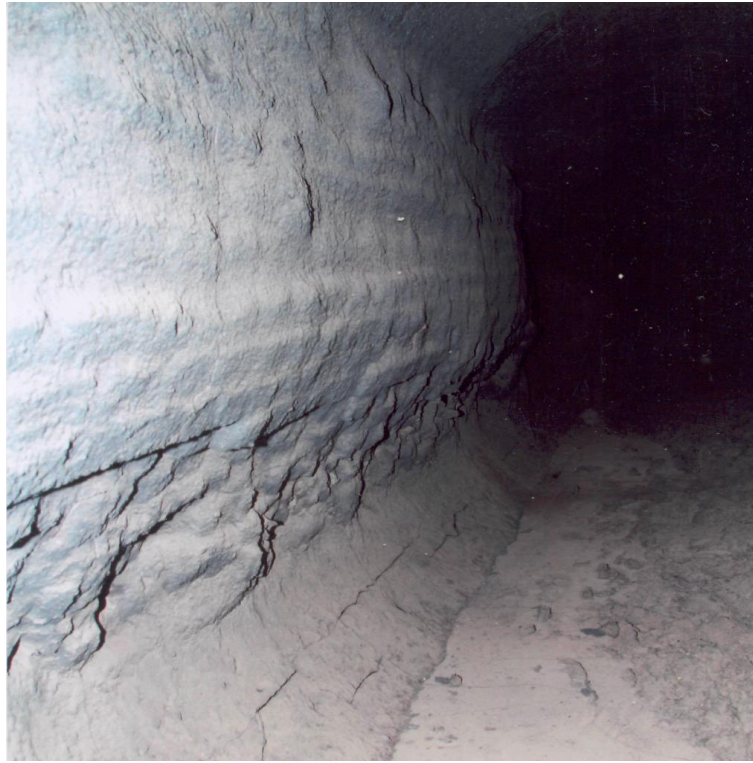
Рисунок 25 - Вид фурменного пояса после 1,5 месяца эксплуатации
