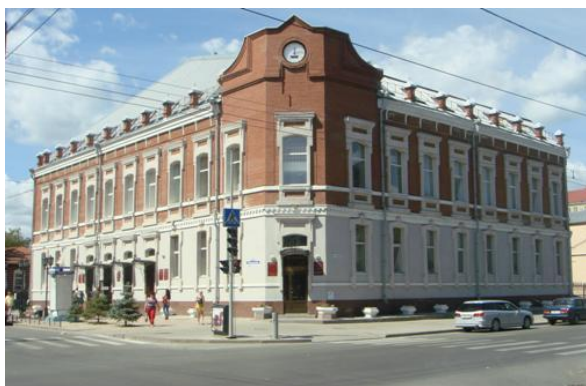
Рис. 16. Здание ИБЦ ТюмГУ
